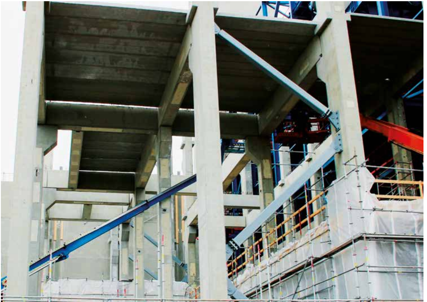
Anstarin ristikkoliitokset on suunniteltu nopeaan asennustapaan sopiviksi ja erityisesti talviasennuksen vaatimuksiin.
